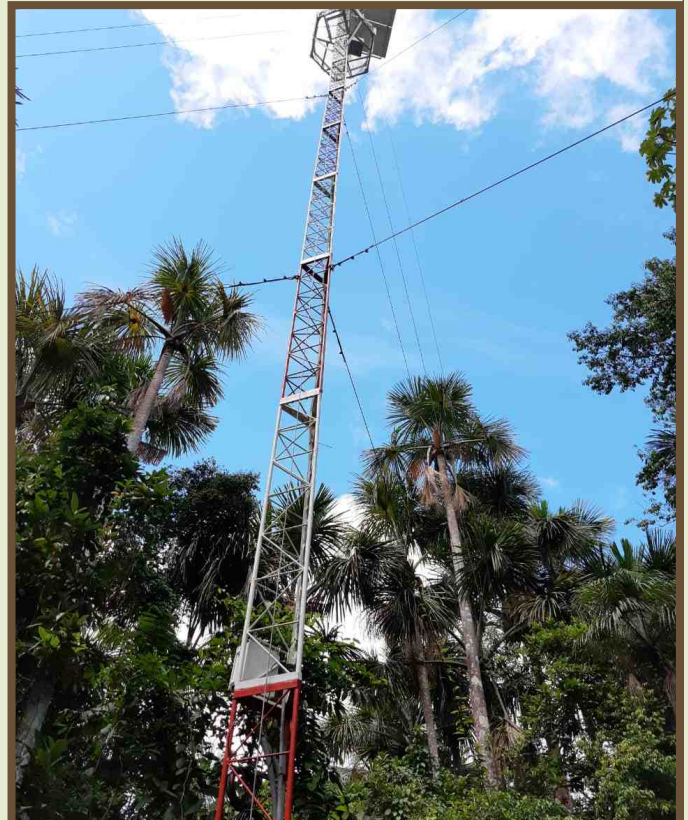
Torre que soporta los equipos de medición de gases de efecto invernadero en el aguajal ubicado en Quistococha, cerca a la ciudad de Iquitos.
