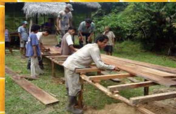
Desarrollo de trabajos participativos de mantenimiento y construcción de infraestructura turística. San Rafael, 2007.
