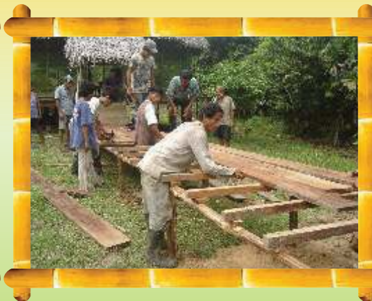
Pobladores participando en la construcción del albergue. San Rafael, 2007.
