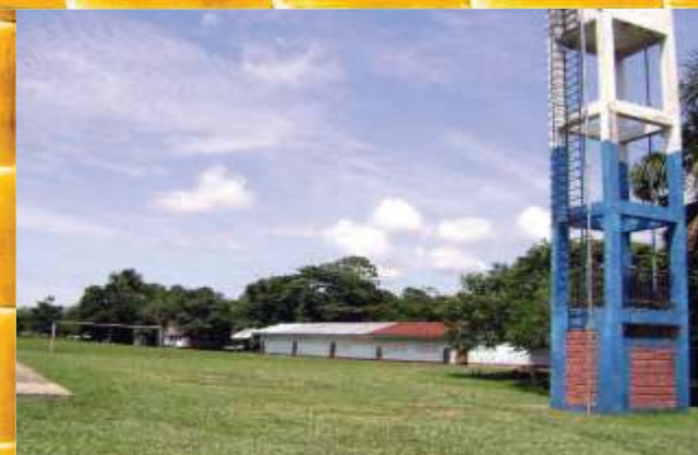
Tanque elevado con agua potable. San Rafael, 2008.
