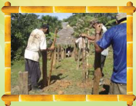
Pobladores participando en la construcción del albergue. San Rafael, 2007.
