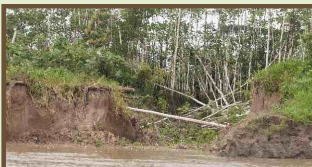
Derrumbe en orilla cóncava del meandro
